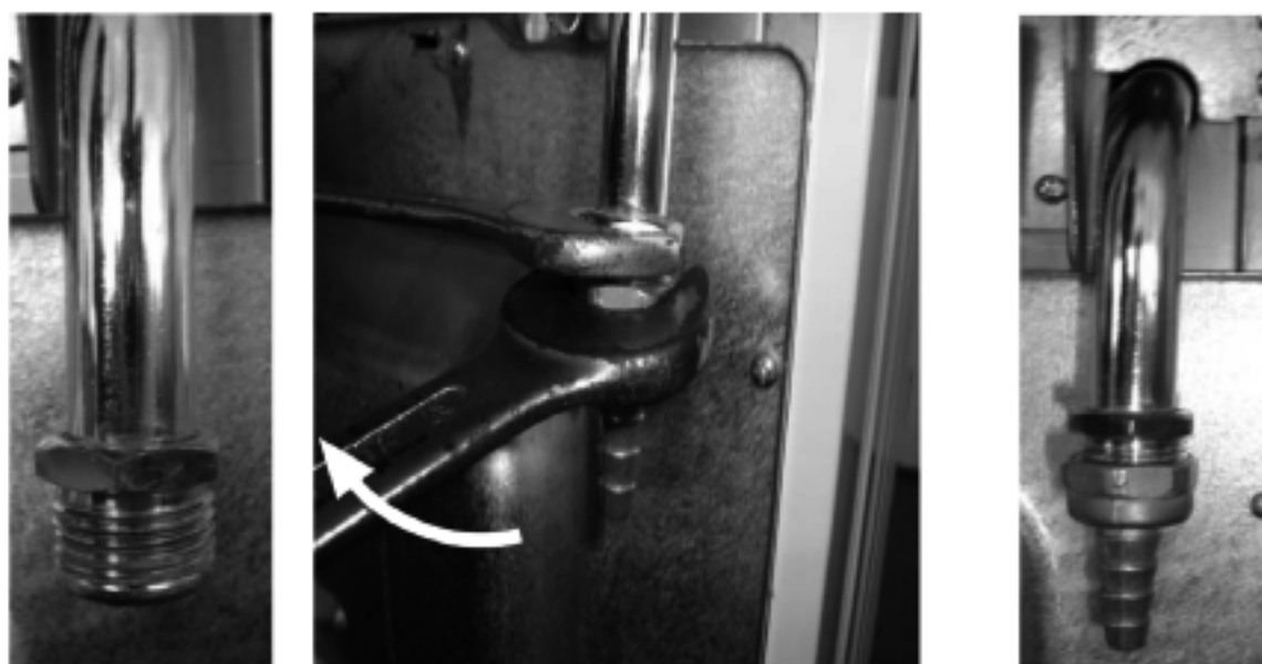
Figure 13 Montage de l'embout gaz butane
